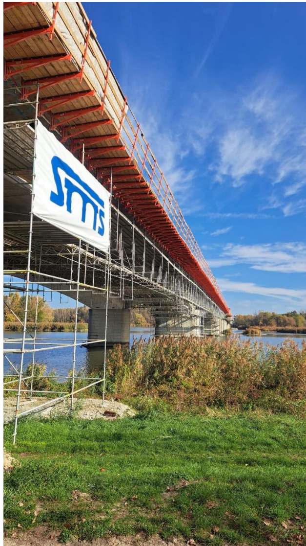
Stavba: Rekonštrukcia mosta ev. č. R1-018 Váhovce, pravý most
