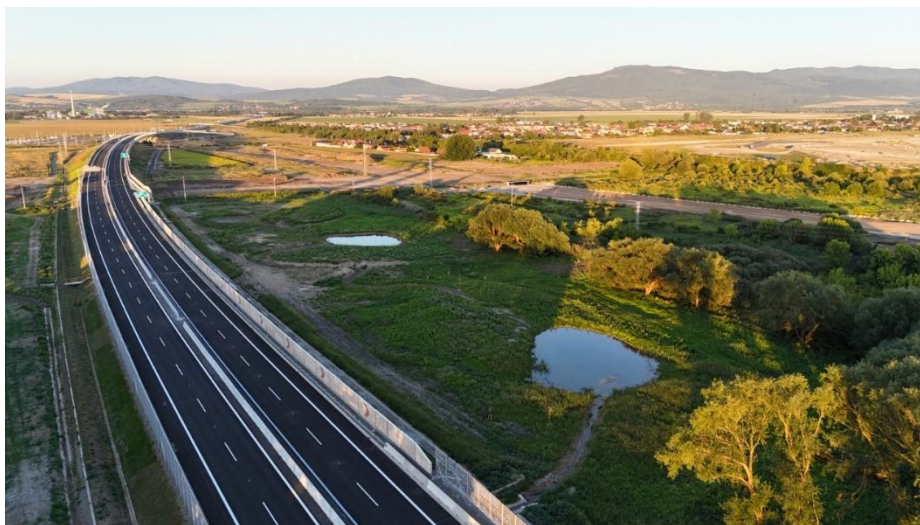
Obrázok: Systém prepojených jazierok na stavbe R2 Šaca – Košické Oľšany
