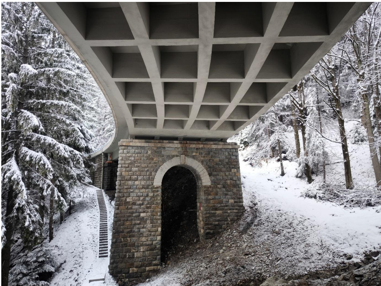
Stavba: Čertovica – Lajštrok – rekonštrukcia mosta
